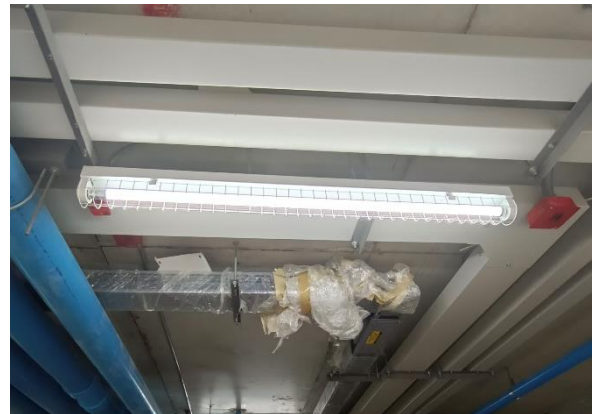
รูปที่ 2.28 หลอดไฟประหยัดพลังงาน (LED)
